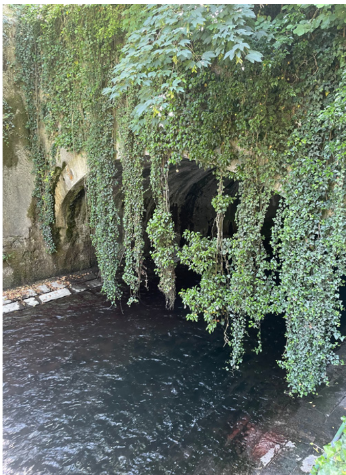
Die in einem Stollen verschwindene Glatt vor der Mündung in den Rhein.
